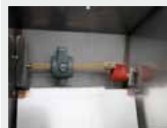
Manchette chauffante pour la soupape (réf. 131.0527)
